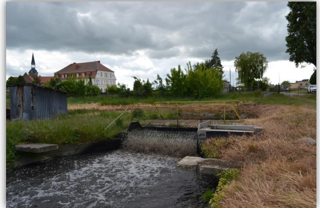
Poprawa stanu gospodarki wodno-ściekowej na terenie gminy
